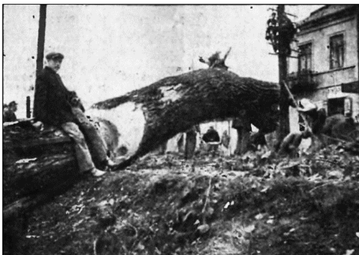
Ryc. 2. Uszkodzenia budynków spowodowane drzewami połamanymi przez huragan
