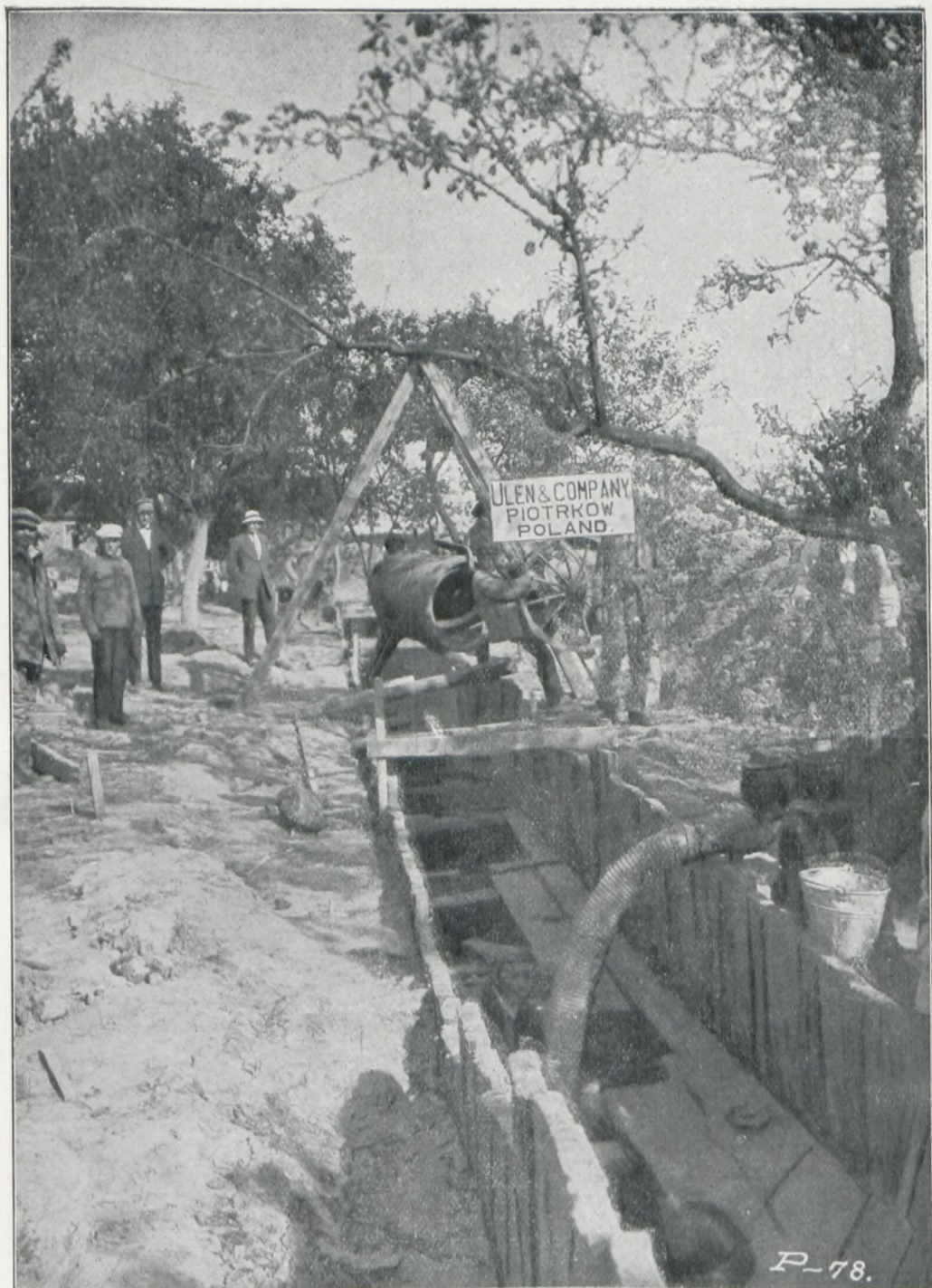
Fot. 5. Piotrków. Układanie rur kanałowych. (Str. 576).
