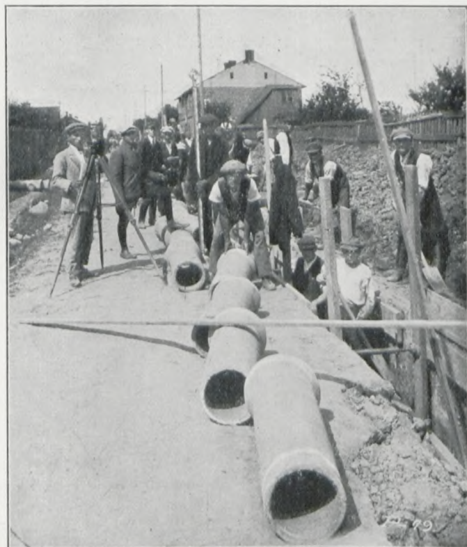
Fot. 4. Piórków. Układanie rur kanałowych. (Str. 576).
