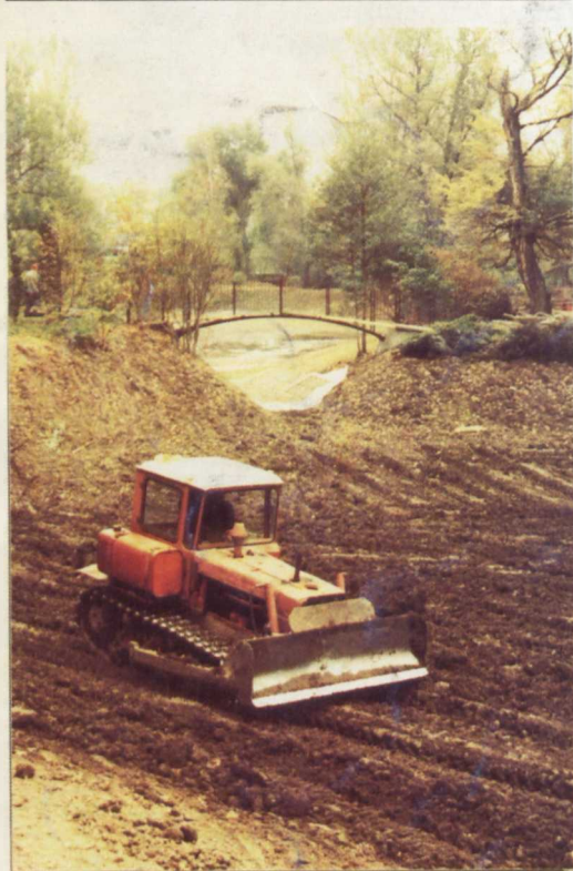
Prace przy renowacji stawów w Ogrodzie Botanicznym Fot. Maciej Przysucha
