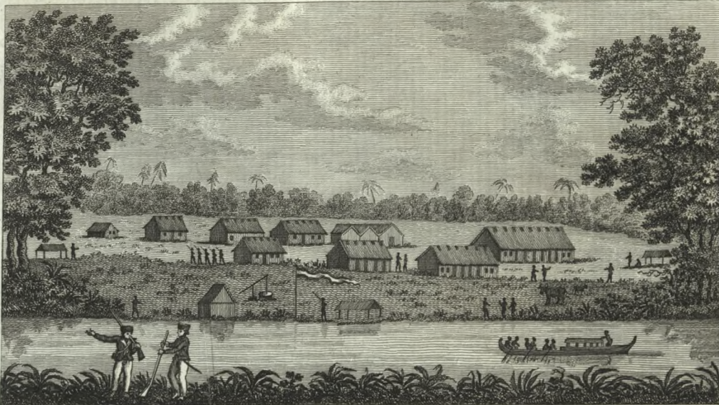
Vue du Poste de Devil's Harbour sur la Cottica
